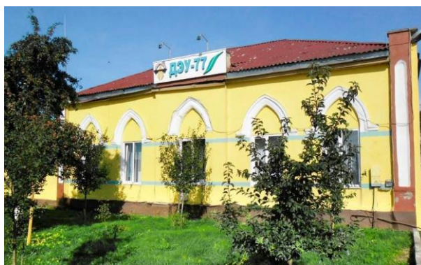
Рисунок 2.9.13 – Здание бывшей почтовой станции
